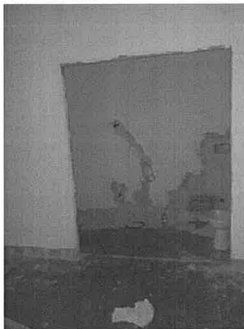
BAGNO IN COSTRUZIONE
